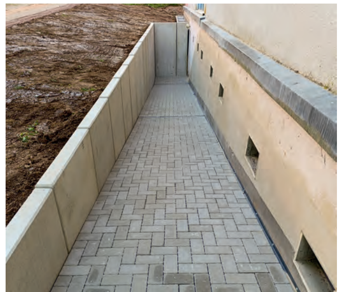
neuer Hofausgang nach Pflasterarbeiten
