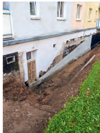
Hofausgang nach den Abrissarbeiten
