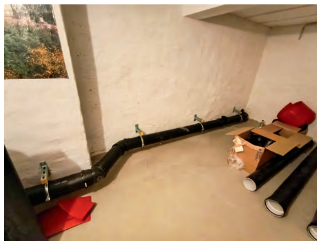
umverlegte Abflussleitung oberhalb Kellerfußboden
