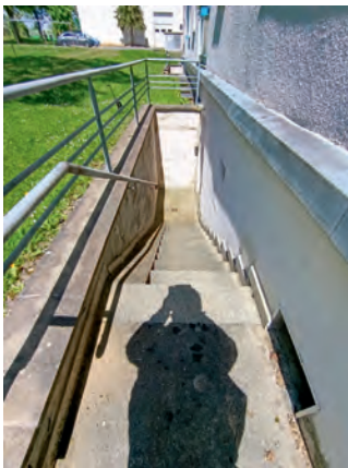
alte Treppenanlage des Hofausganges
