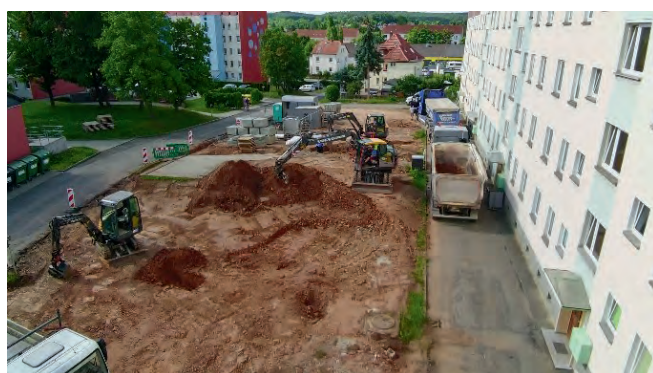
freimachen Baufeld Neustädter Straße 54 – 56a
