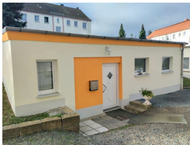
Hausmeisterstützpunkt nach Anstrich
