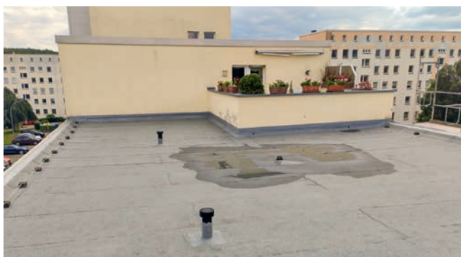
Sanierte Dachfläche mit allen Anschlüssen. Zu erkennen ist hier das Gefälle zum Dacheinlauf nach einem Regentag.
