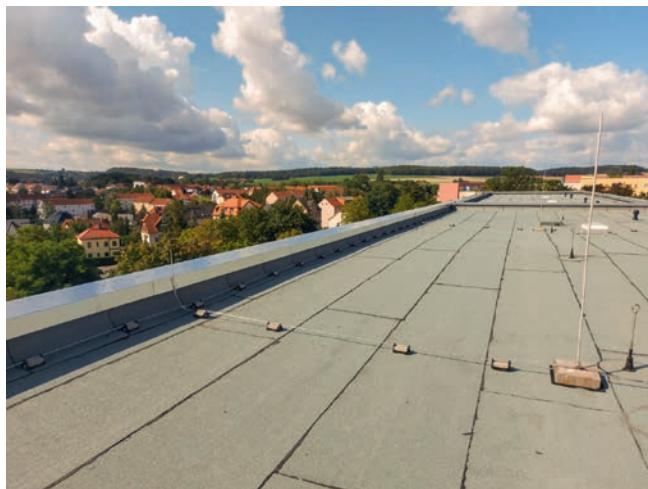
Saniertes Flachdach auf Wohnblock Nr. 1 – 1c Foto: Selle
