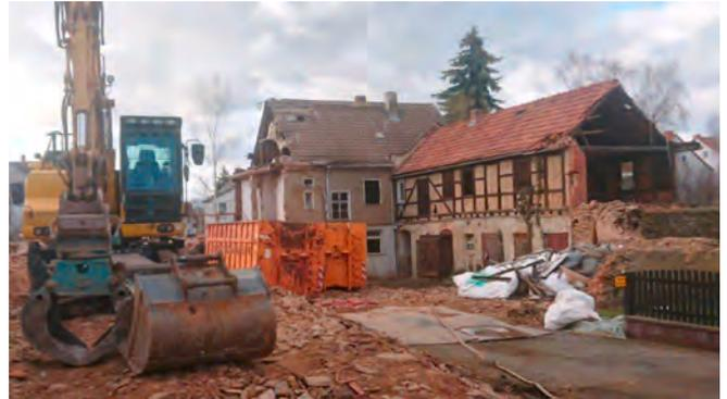
*Abtrag des Daches und der Mauern mittels eines größeren Abrissbaggers*
