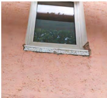
Neben der Neueindeckung des Daches incl. Klempnerarbeiten wurden alle Sohlbänke gegen Aluminium-Sohlbänke ausgetauscht, notwendige Verputzarbeiten vorgenommen, der Blitzschutz erneuert und die Fassade vierseitig neu gestrichen. Die Malerarbeiten und teilweise Verputzarbeiten haben die AWG-Handwerker ausgeführt.
