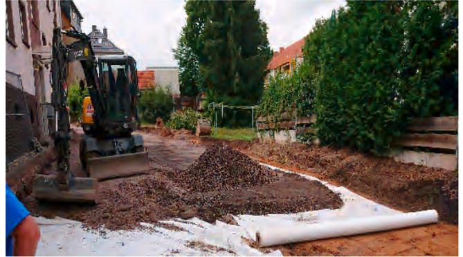
Verstärkter Unterbau und Einbringen von Gewebe zum Lastausgleich
