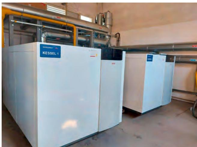
Bild von neuen Brennwertkesseln
